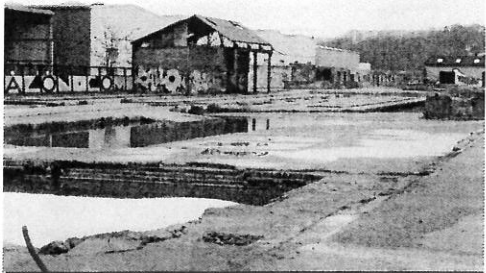
Vue de l'entrée bâtiments déconstruits
